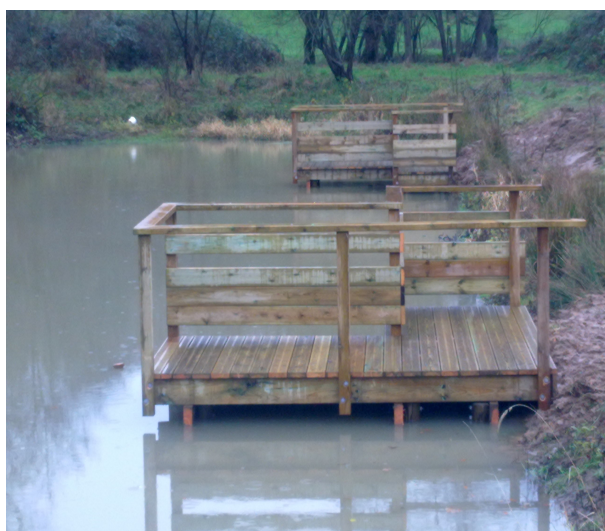
Fin des travaux
