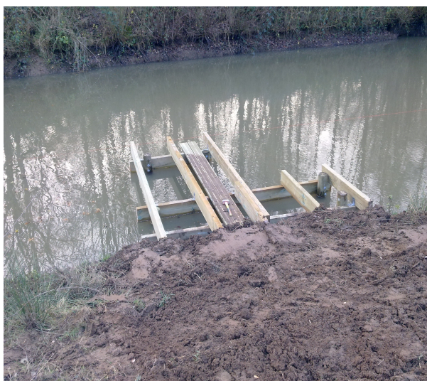
Début des travaux
